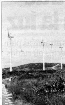
Molinos en Casares (Málaga).
