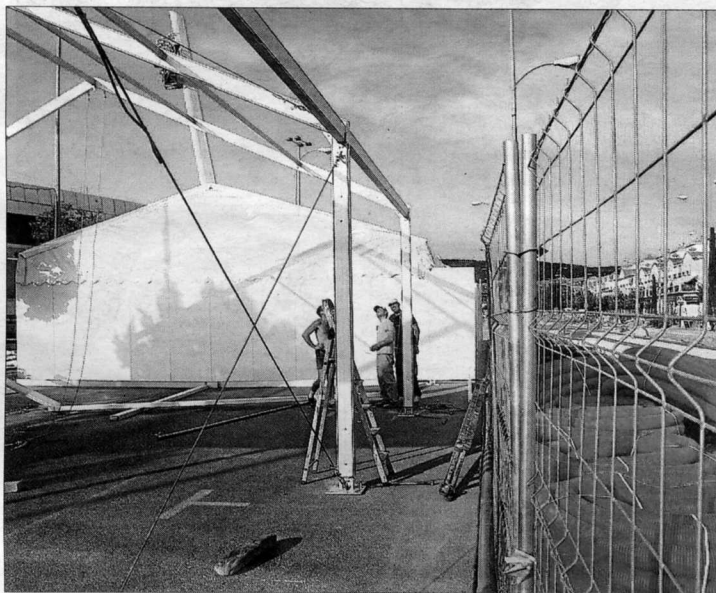
Montaje de las casetas del ferial, limitadas por la valla que las separa de las obras del metro.
