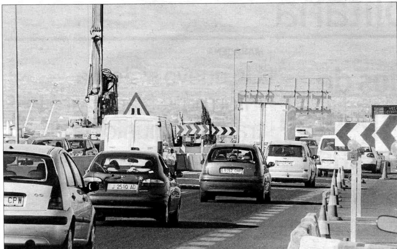
Los trabajos obligan a circular a 40 kilómetros por hora, lo que provoca algunas retenciones. JUAN PALMA
