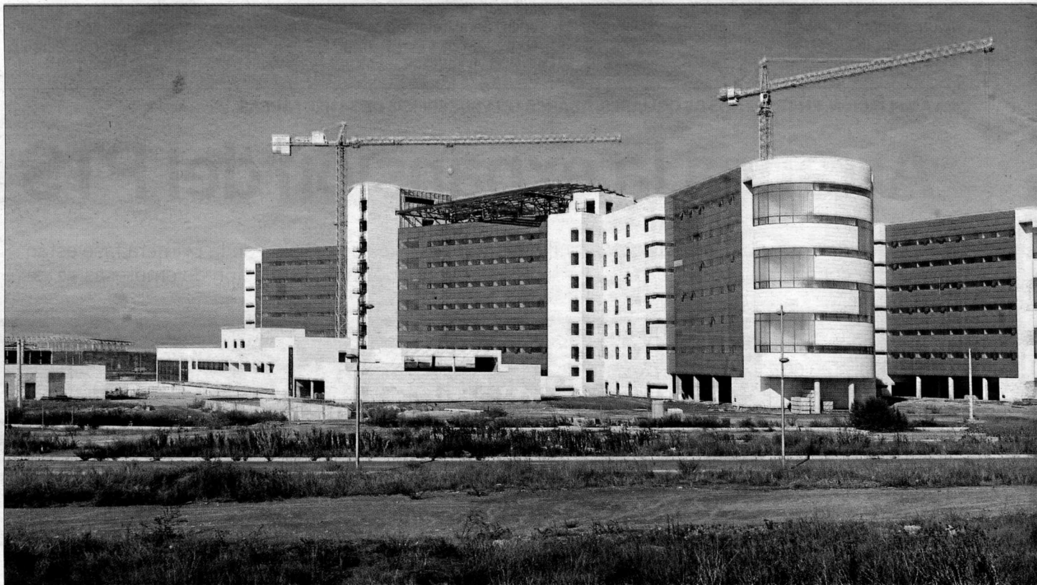
Vista de la construcción del hospital Clínico, uno de los proyectos más importantes que tendrá cabida en el PTS. CHARO VALENZUELA
