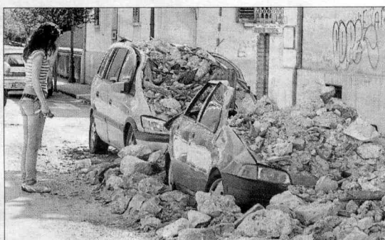
Destrucción. Los escombros cubrían los coches en L'Aquila. EFE
