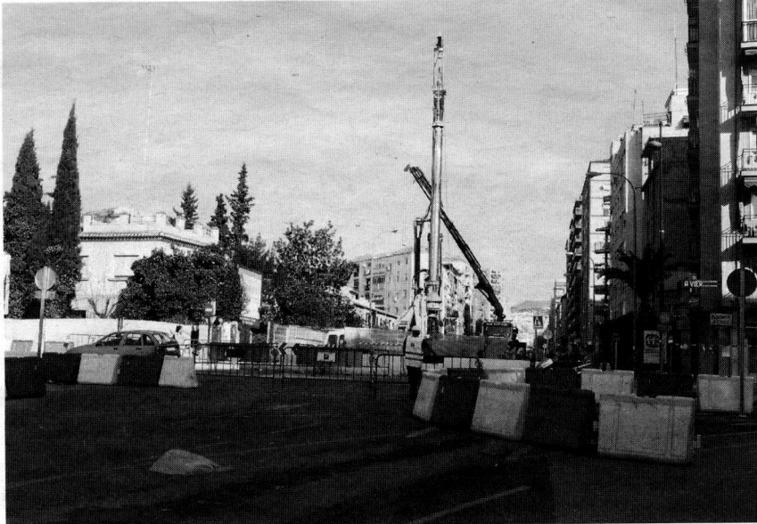
Detalle de las obras del Metro en la Avenida de América.
