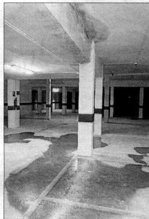
**Goteras.** Filtraciones de agua en las cocheras.
