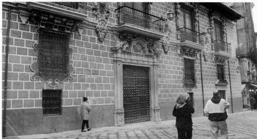
Las obras de la tercera fase durarán 20 meses.
