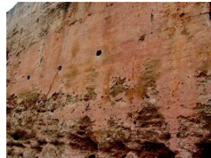
Knochenmehl diente zur Verfestigung von Mauern in Mittelalter. Foto: American Chemical Society
