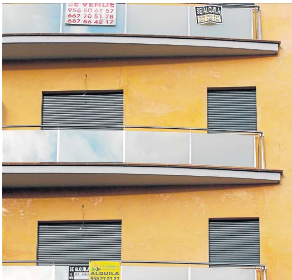
Bloque de reciente construcción con varios anuncios de alquiler en la Carretera de Armilla.
