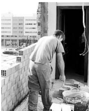
Un albañil, en la terraza de una casa. ARCHIVO
