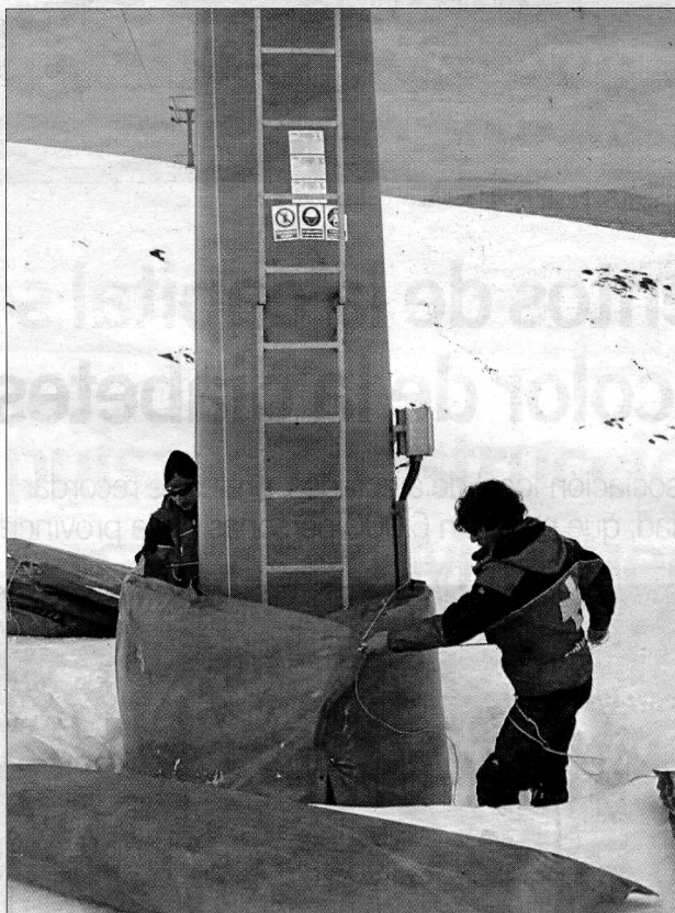
Dos pisteros acolchan un remonte en las inmediaciones del Veleta. L.O.
