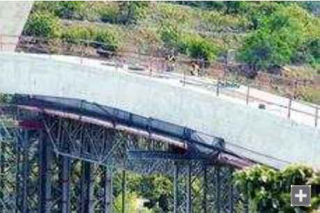
Trabajos de reconstrucción del viaducto de la A-7 en abril.
