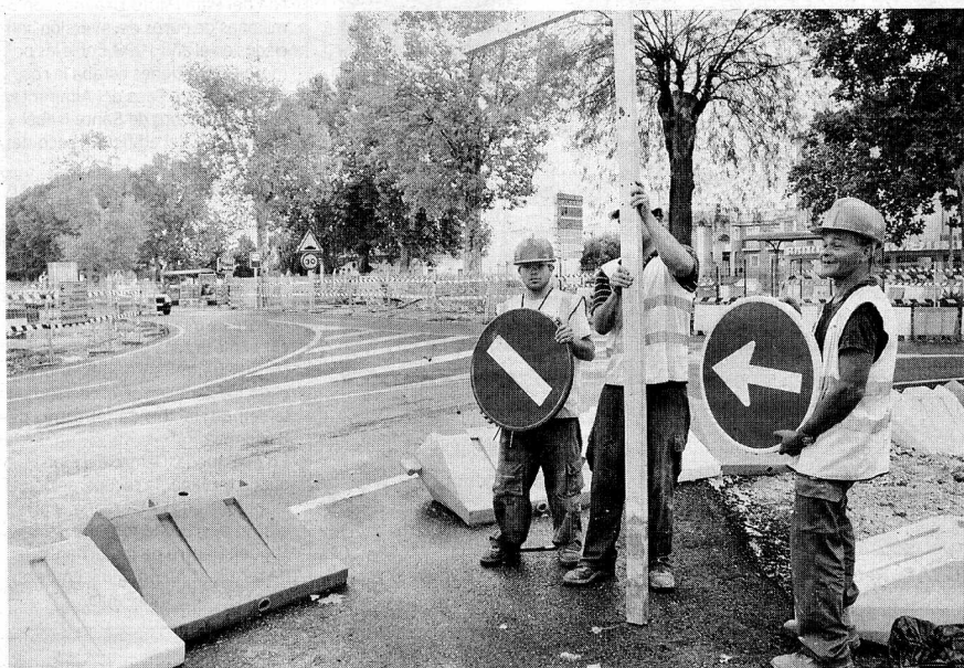
PREPARADOS. Los trabajadores ultiman los trabajos para el corte que se iniciará hoy. / R. L. PÉREZ
