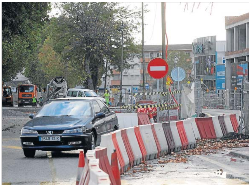
Itinerario alternativo a la carretera habitual, en obras, a pocos metros de la entrada de Armilla.
