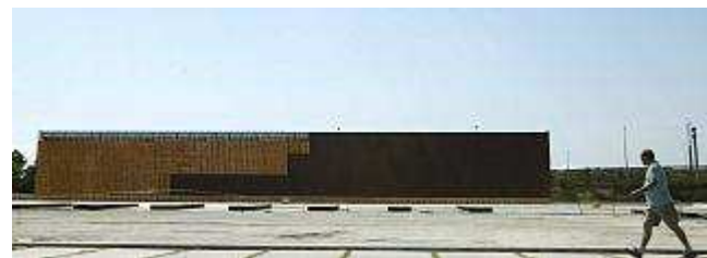
Una imagen del edificio central del MUA, que alberga la sala 365, cuya fachada se está restaurando por completo BIEL CALDERÓN
