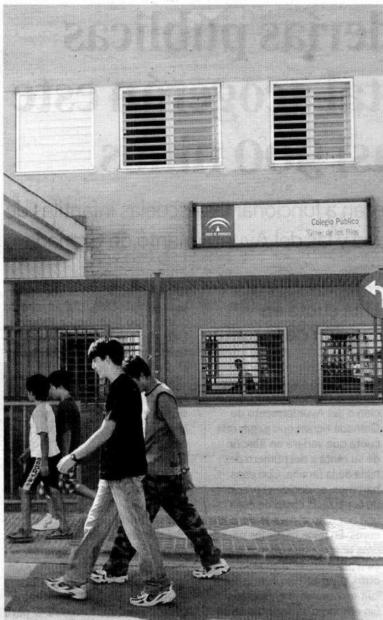
Las obras comenzarán en breve en el Colegio Giner de los Ríos. GRANADA HOY
