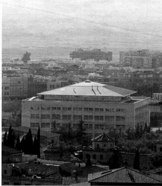
Assyce instalará en la ETS de Caminos cubiertas fotovoltaicas. PEPE VILLOSLADA
