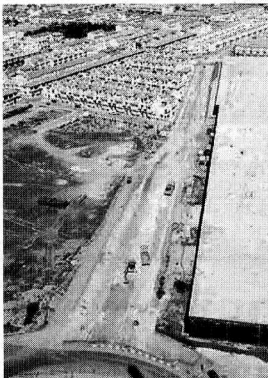
Obras junto al Nevada.
