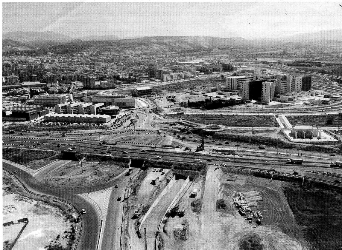
Vista aérea de las obras del Metro junto a la A-44, donde se realiza un paso inferior para la conexión con el PTS.
