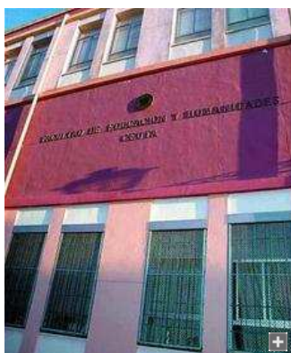
La facultad necesita obras que la modernicen.
