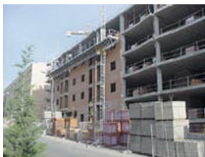
Un edificio en proceso de construcción. (GD)
